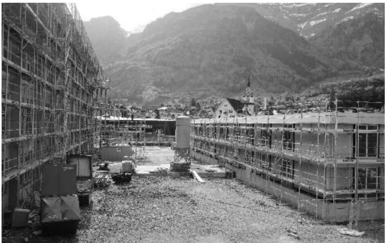
Baustelle mit Innenhof
