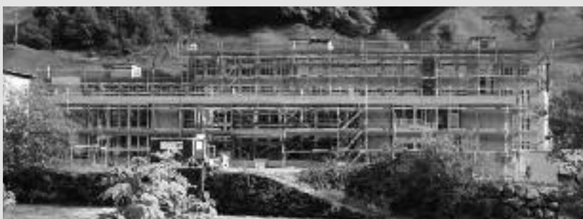
Mühleareal Schwanden, Um- und Neubau
